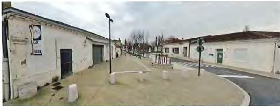
Les commerces et services, place de Verdun (source : Google street)
